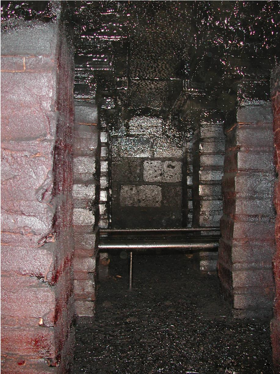
Abb. 10: Schmierruß (oben) und Glanzruß (unten) im hypokaustum unter dem caldarium. – Tarry soot (top) and shining soot (bottom) in the hypocaust under the caldarium.
