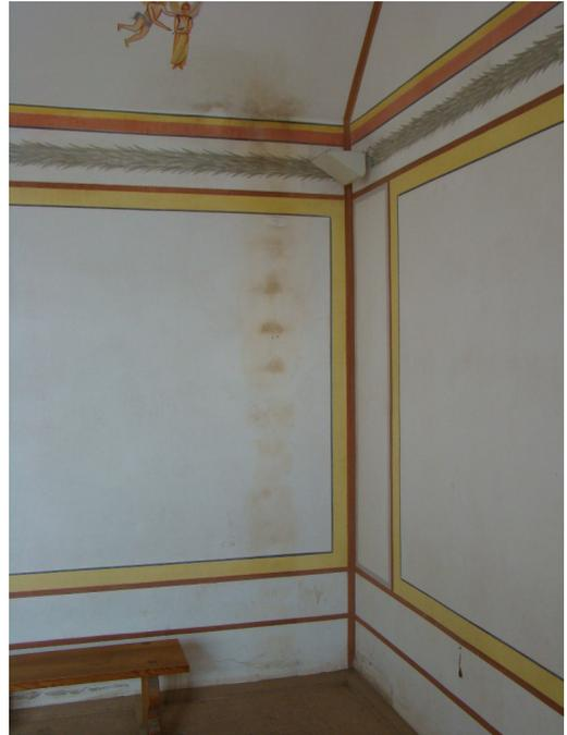
Abb. 3: Versottung im *tepidarium*. – Corrosive condensation in the *tepidarium*.
