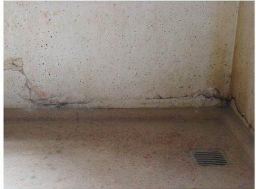
Abb. 5: Waagerechte Risse über dem Fußboden im *caldarium*. – Horizontal cracks above the floor of the *caldarium*.
