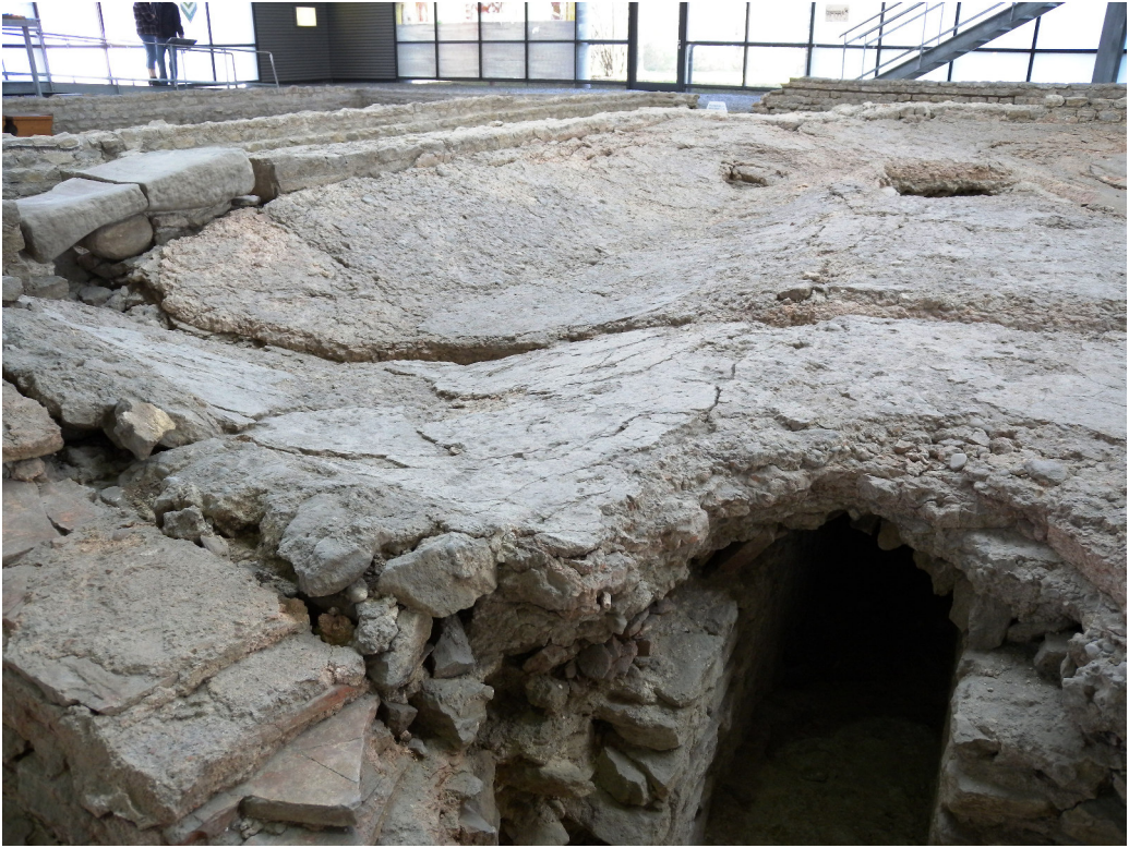
Abb. 6: Wellenförmig verformter Boden in den Kleinen Thermen von Cambodunum. – Wave-like distorted floor in the Kleinen Thermen von Cambodunum.
