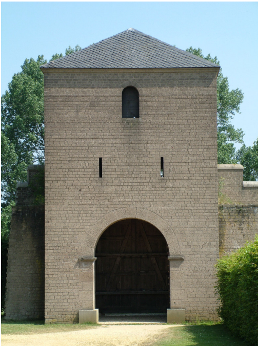
Abb. 6: Rekonstruierter Stadtmauerturm in Xanten mit Tordurchfahrt mit Gewölbesteinen ohne Profilierung. – Reconstructed city gate in Xanten with plain voussoirs.
