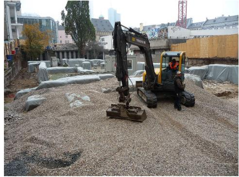
Abb. 5: Auffüllung des Areals zum Schutz der historischen Mauern vor Beginn der Bauarbeiten. – The backfilling of the area to protect the historical masonry before starting the construction works.
