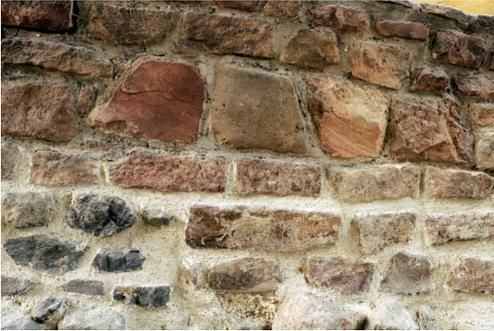
*Abb. 6: Im Originalbestand des Mauerwerkes wurde der Zementmörtel (oben) durch kalkgebundenen Restaurierungsmörtel (unten) ersetzt. – The modern cement in the gaps of the historical masonry (above) was replaced by reconstructed mortar (below).*
