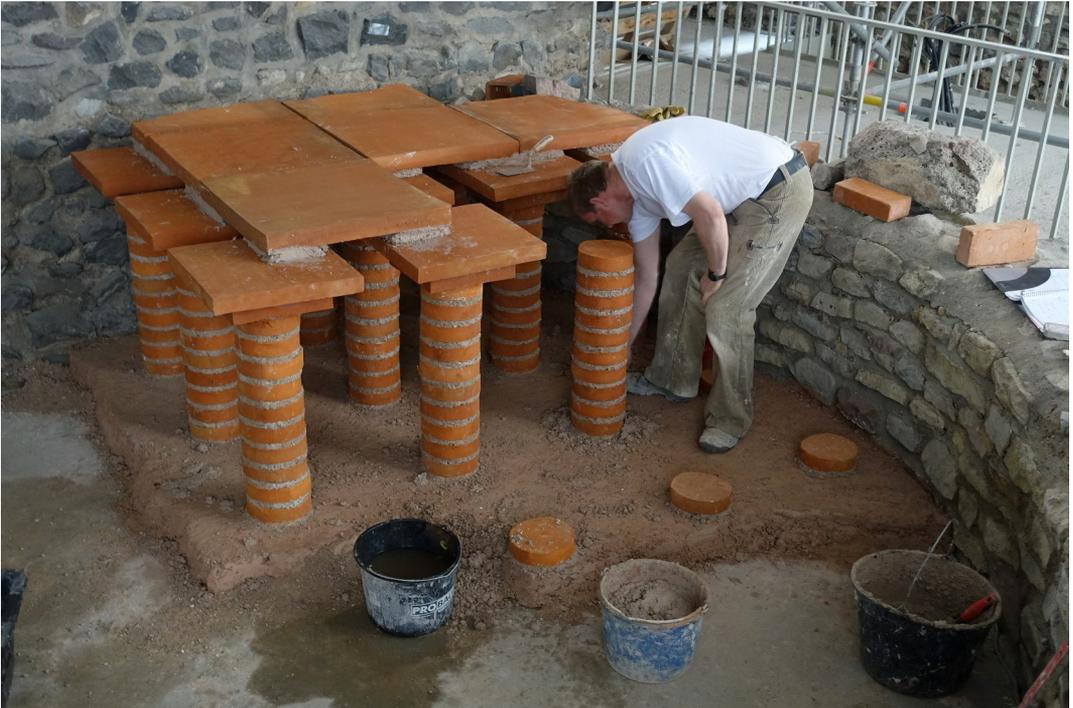
*Abb. 7: Aufmauern der rekonstruierten Hypokaustziegel im sudatorium des römischen Bades. – Bricking up the reconstructed tiles in the sudatorium of the roman bath.*
