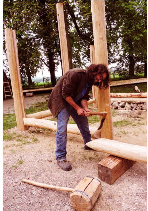
Abb. 5: Die Schwellbalken wurden aus Eichenholz gefertigt und greifen mit V-förmigen Enden in vertikale Schlitze der Pfosten ein. – The sill beams were made of oak and have V-shaped ends reaching into vertical slots of the post.
