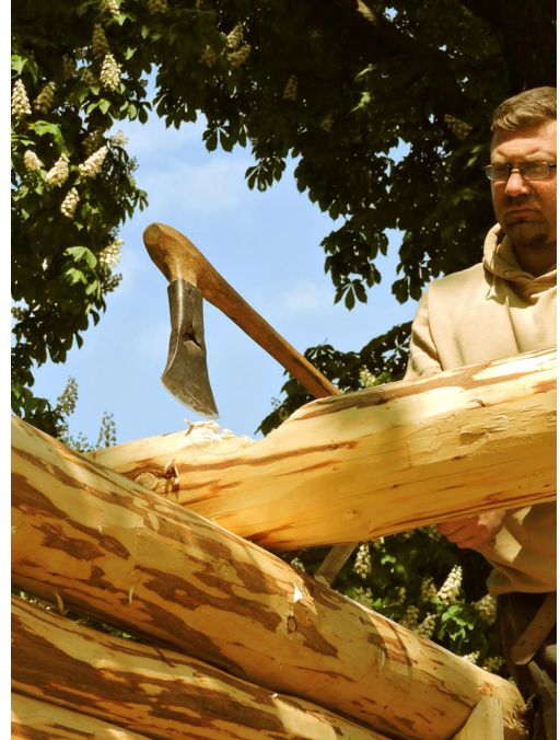
Abb. 7: Tüllenbeile der jüngeren Eisenzeit waren gut geeignet, um halbrunde Ausnehmungen vorzunehmen. – Socketed hatchets of the younger Iron Age turned out to be good implements for carving half round notches.
