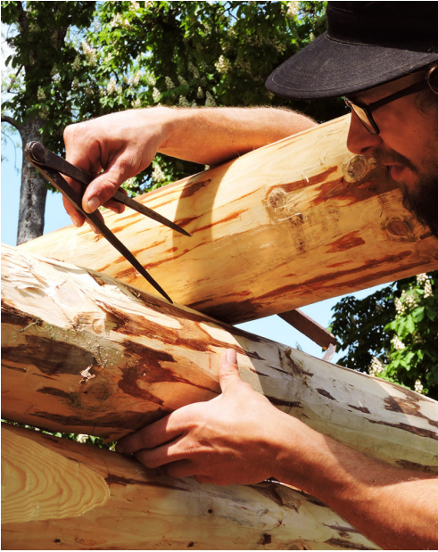
Abb. 6: Die individuellen Wölbungen der Fußpfetten wurden mit einem Zirkel auf die Unterseiten der Binderbalken übertragen. – The individual curvatures of the wall plates were transferred to the tiebeams with a pair of iron compasses.
