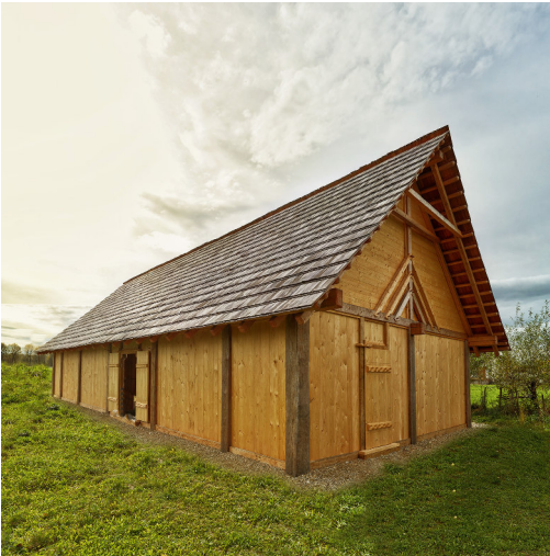
Abb. 14: In den Jahren 2017 und 2018 wurden das Haus und auch die Inneneinrichtung fertig gestellt. Schwellbalken und Türstöcke bestehen dabei aus Eichenholz, Wände, Giebel und Türen aus Fichtenbohlen. – In 2017 and 2018 the house and also the inside furnishings were finished. The sill beams and the door frames were made of oak, the walls, gables and doors were constructed of spruce planks.
