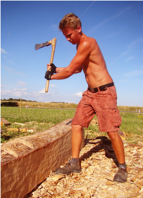
Abb. 4: Mit einer Beilklinge wurden quer zur Faser bis zur Markierungslinie Kerben eingehackt, damit die Segmente dazwischen mit Holzkeilen abgespalten werden konnten. – Using a hatchet we worked notches down to the marked lines of the timber and split off the segments in between with wooden wedges.
