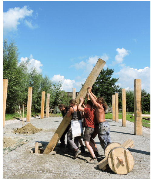
Abb. 6: Mit den vereinten Kräften von sechs Personen gelang es uns, auch die schwersten Eichenpfosten mit Gewichten von bis zu 400 kg aufzurichten; im Vordergrund unser Transportwagen. – With the strength of six persons we managed to erect even the biggest oak posts with estimated weights of about 400 kg; in foreground our transport cart.
