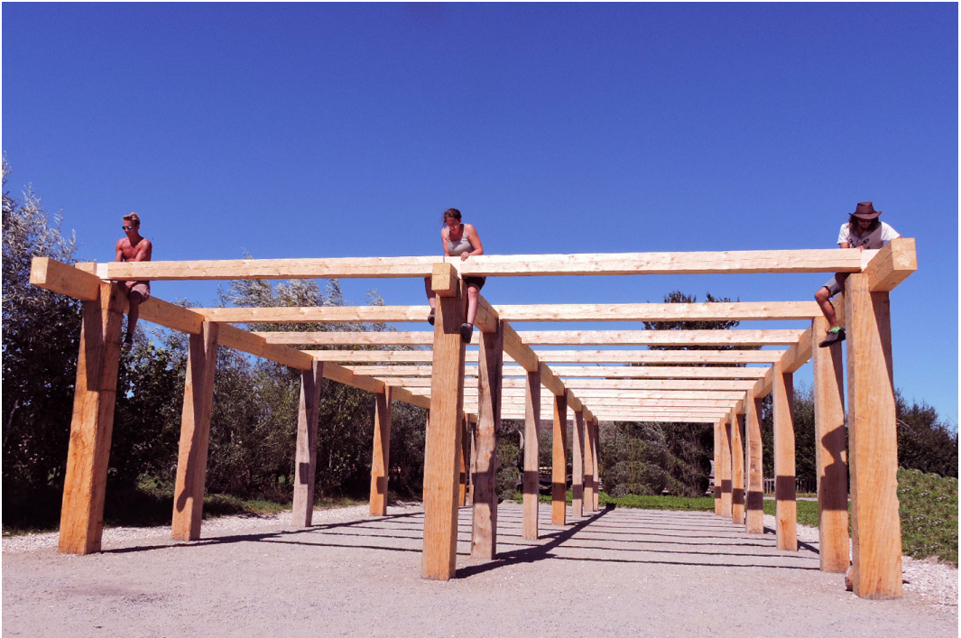
Abb. 9: Der letzte Binderbalken wird in die vorgearbeiteten Lagerfugen eingesetzt. Aus Stabilitätsgründen wurden die Binderbalken aus jeweils einem Stück Holz von mehr als 9 m Länge gearbeitet und verbinden so die drei Pfostenreihen zu einer Einheit. – The last tie beam is positioned. Due to stability each tie beam was made of one single piece of wood with a length of more than nine meters. They connect the three post rows transversally.
