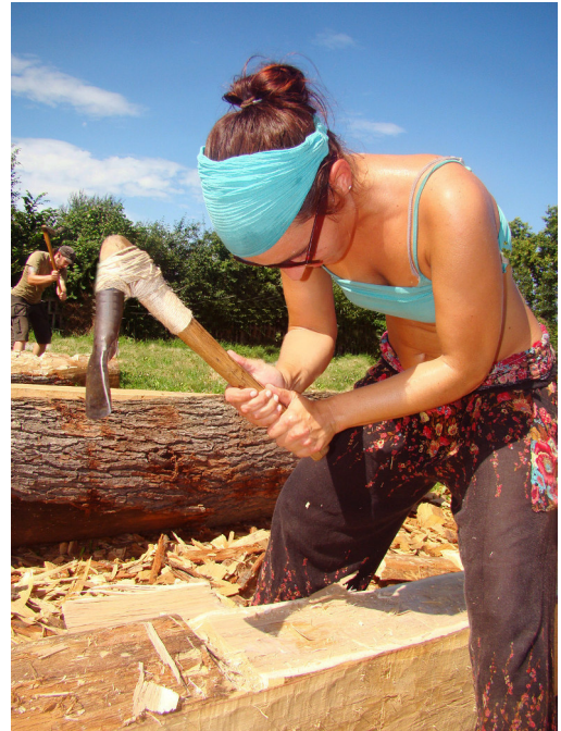
Abb. 5: Um die Oberflächen der rechteckigen Bauhölzer zu glätten, wurden bei der finalen Feinarbeit Lappendeckseln auf Knieholzschäftungen eingesetzt. – To give the rectangular building woods a smooth finish we used adzes on knee-haftings.
