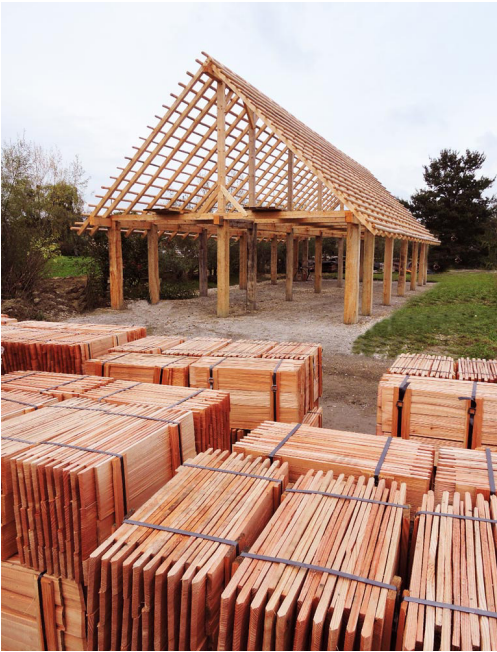
Abb. 13: Die Dachschindeln aus gespaltenen Lärchen sind vorbereitet. Um ein dichtes Dach zu erhalten, müssen sie so gesetzt werden, dass sie sich gegenseitig überlagern wie die Schuppen eines Fisches. – The shingles of split larch wood are prepared. To get a leakproof roof they have to be put on the laths in a way that they overlap each other like the scales of a fish.
