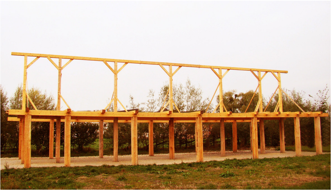
Abb. 11: Die Firstsäulen und auch die Firstpfetten sind aufgesetzt und mit Streben und Holznägeln gesichert. Ansicht des Hallenhauses von Osten. – The crown struts and the apex purlin are set up and were fixed with sloping braces and wooden nails. View of the house from the east.
