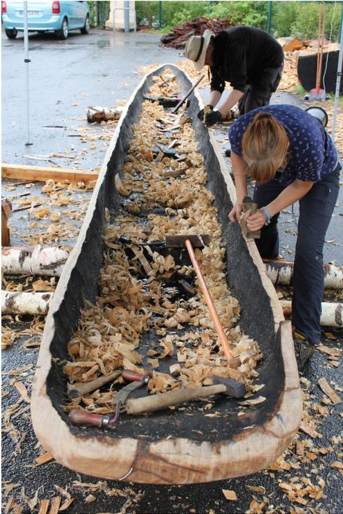
Abb. 9: Die letzten Arbeiten an der Dollbordkante. – The last work on the gunwale.
