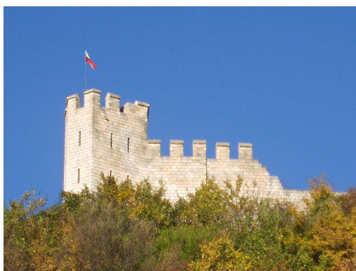
Abb. 3: Der restaurierte südöstliche Turm der Festung. – The restored southeastern tower of the Shumen fortress.
