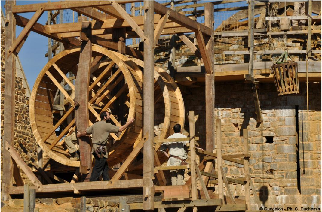
Abb. 6: Doppeltes Laufrad (Kran) für den Bau des Hauptturms. – Double treadwheel crane for the construction of the main tower.
