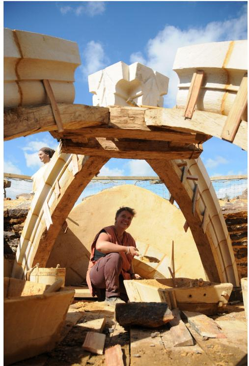
Abb. 7: Kreuzrippengewölbe der Burgkapelle mit stützendem Lehrgerüst. – Crossed rib vault of the castle's chapel with supporting wooden centering.
