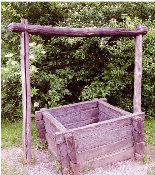
Abb. 1: Das erste Brunnenmodell nach 18 Jahren in der Erde. – Our first well replica's box-frame after 18 years in the soil.
