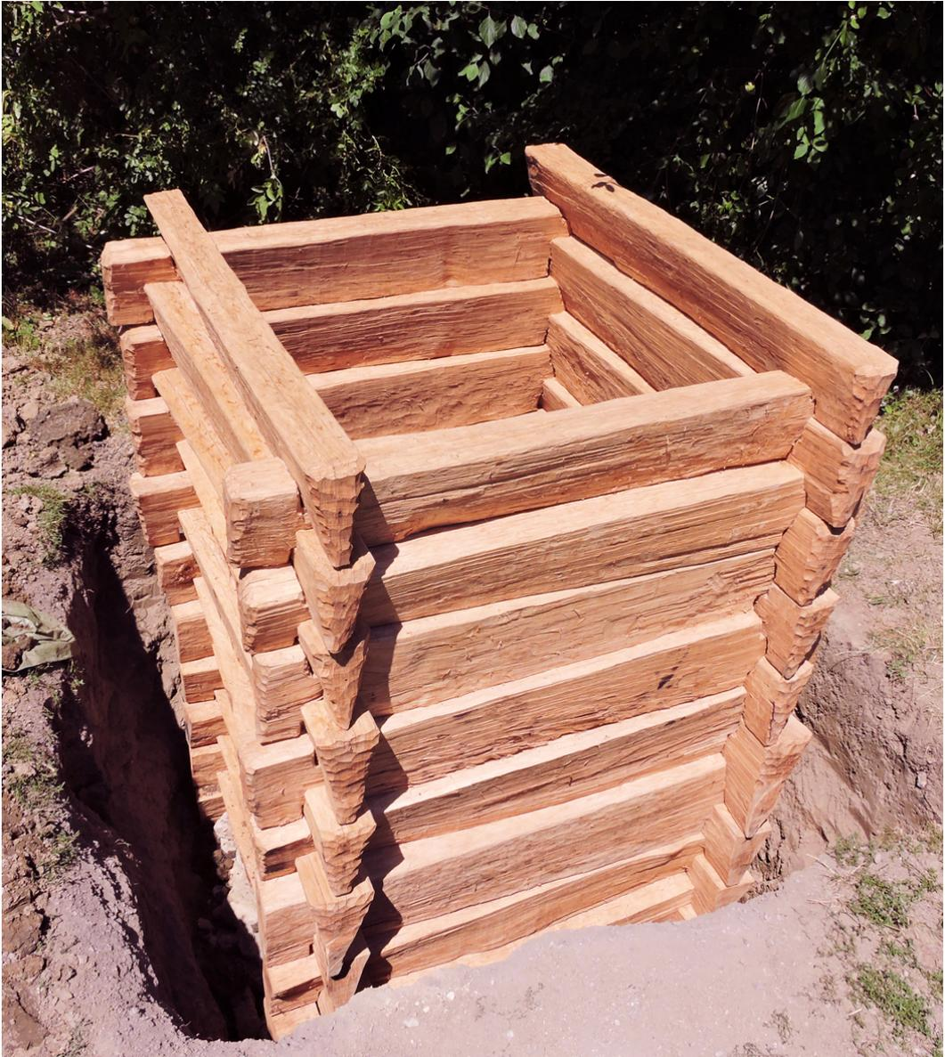
*Abb. 11: Der Brunnenkasten wird in der Baugrube errichtet. – The well's box-frame is erected in the construction pit.*
