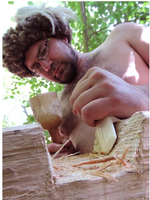
Abb. 9: Die Ausklinkungen für den Blockverband wurden mit Knochenbeiteln ausgestemmt. – Recesses in the construction elements, indispensable for the employment of the log cabin method, were cut out with bone chisels.
