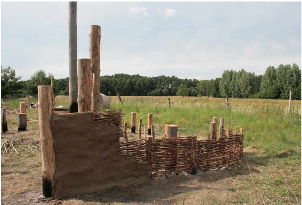
Abb. 4: Teil der rekonstruierten Flechtwerkwände mit Lehmputz „im Arbeitsprozess“. – Part of the reconstructed wattle and daub wall “in working progress”.
