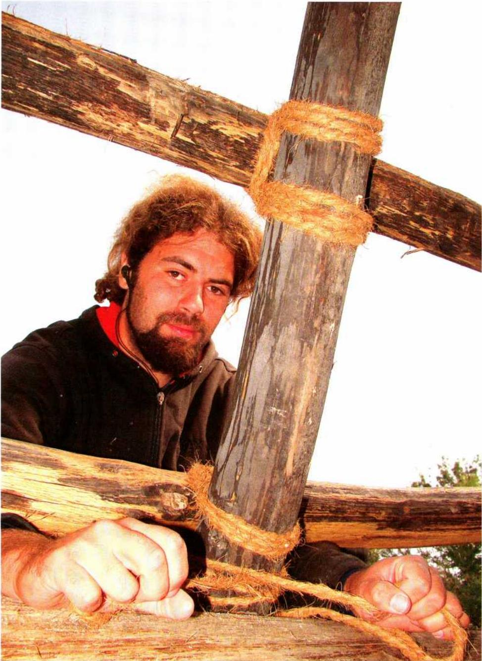
Abb. 8: Die Konstruktionselemente im Dachbereich wurden durch Seile miteinander verbunden. – The construction elements of the roof were connected with rope bindings.
