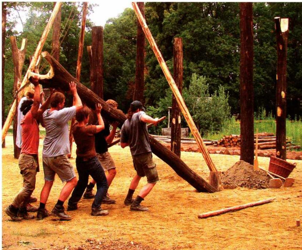
*Abb. 4: Einige der großen Innenpfosten des Hauses wurden von Hand aufgestellt. – Some of the large inner posts of the house were erected by hand.*
