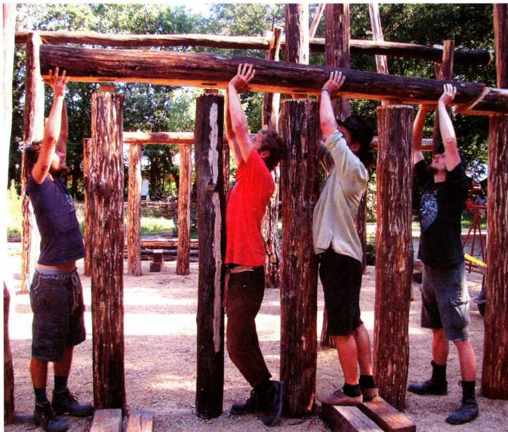
*Abb. 6: Die Unterseiten der Fußpfetten wurden mit Dechseln flächig überarbeitet und mit rechteckigen Löchern versehen, um die Zapfen an den oberen Enden der Seitenpfosten aufzunehmen. – The undersides of the wall plates were flattened with adzes and showed rectangular holes to take up the central tenons on the upper sides of the wall posts.*
