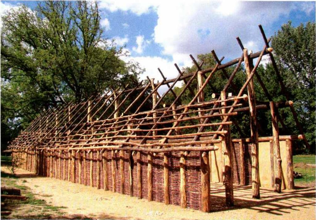
*Abb. 7: Die Konstruktion unseres Hausmodells mit Pfosten, Pforten, Binderbalken, Rofen und Latten; einige Wandfächer zeigen bereits Flechtwerk und Lehmverputz. – The construction of our house model with posts, wall plates, purlins, tie beams, rafters and lath woods; some parts of the wall show already wattle and clay plaster.*
