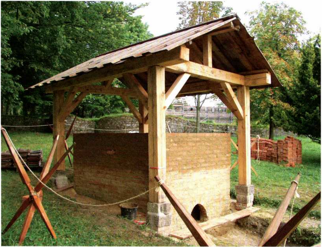
Abb. 6: Der fertiggestellte Ziegelofen mit hölzernem Dach. – The completed brick kiln with wooden roof.
