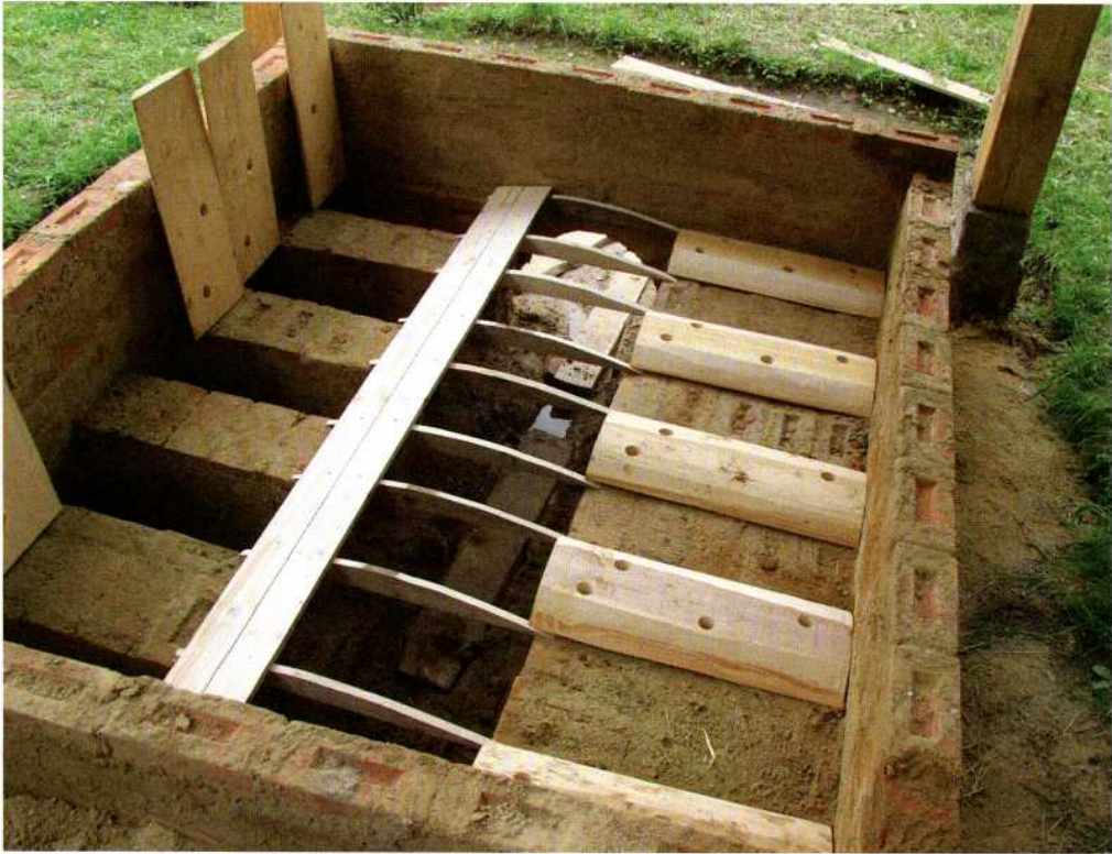
Abb. 4: Die Holzverschalung für die Brenntenne. – The timber cladding for the roof of the fire chamber.
