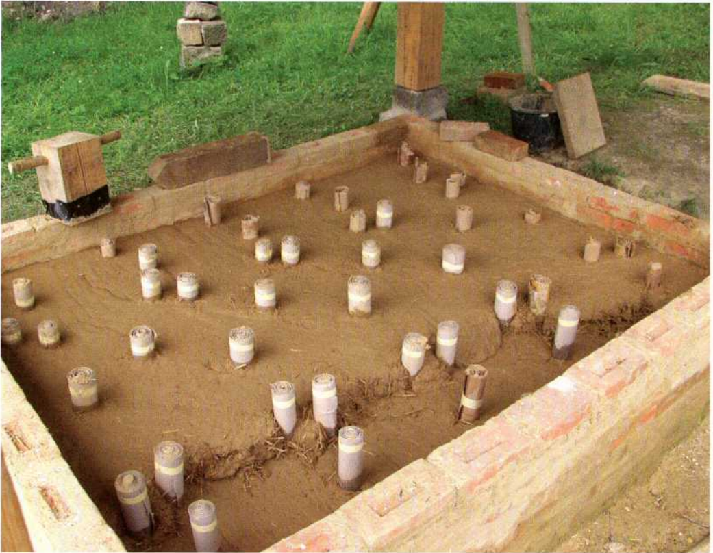
Abb. 5: Fertigung der Brenntenne. – Building the roof of the fire chamber.
