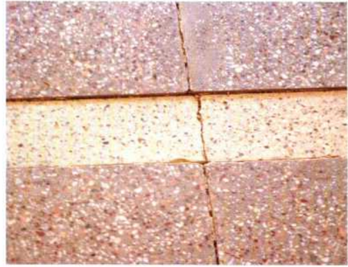
Abb. 4: Risse und Höhenversatz im Boden der Basilika Thermanum. – Clefts and differences of level in the floor of basilika thermanum.
