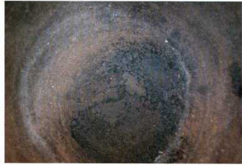
Abb. 8: Einbrennspuren. – Burn-in traces.
