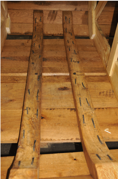
Abb. 3: Bodenwrangen: Querverstrebungen im Schiffsinneren. – Bodenwrangen: cross sections inside the ship.
