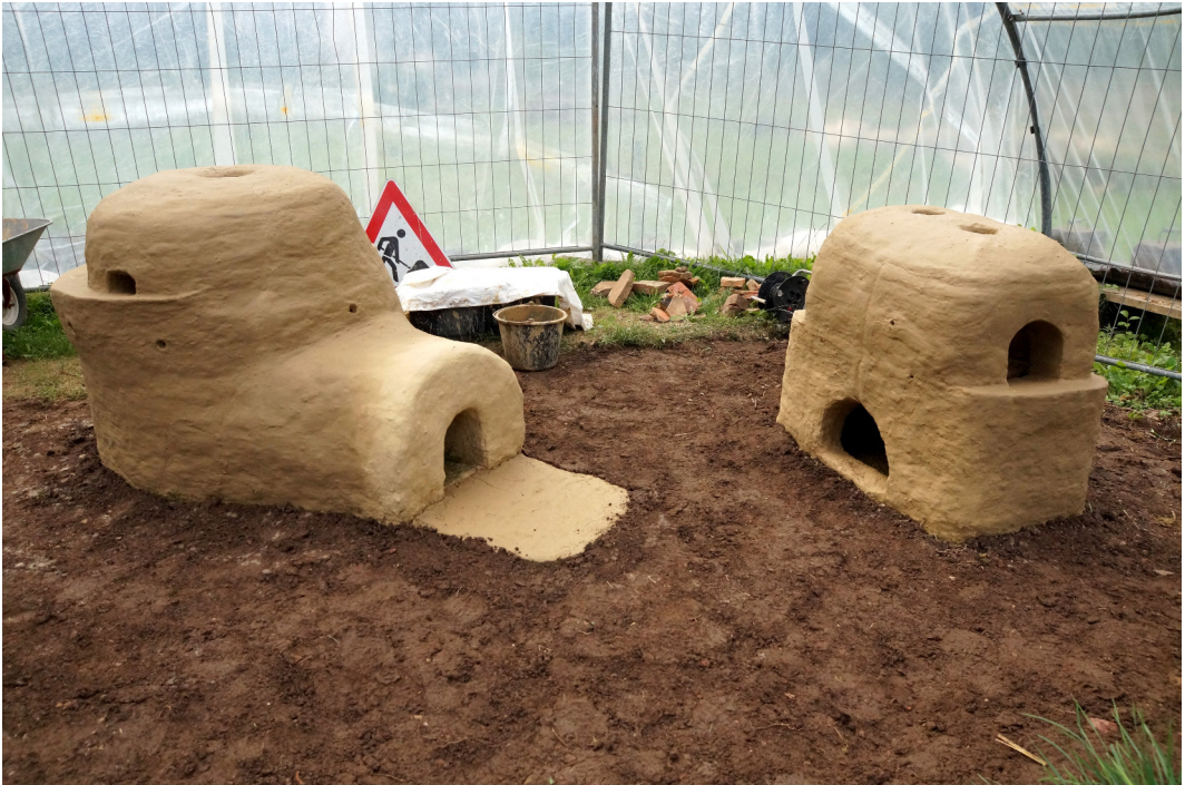
Abb. 2: „Römischer“ Glas-Schmelzofen „GO-Borg 1“ und Kühlofen „KO-Borg 1“ kurz vor ihrer Fertigstellung (20.09.2013). – Roman-style glass furnace “GO-Borg 1“ and lehr (cooling oven) „KO-Borg 1“ almost finished (20.09.2013).
