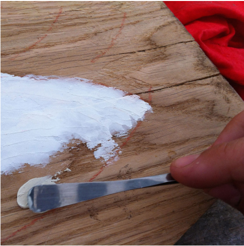
Abb. 4: Auftrag der Farbe mit dem Spatel. – Applying paint with a spatula.
