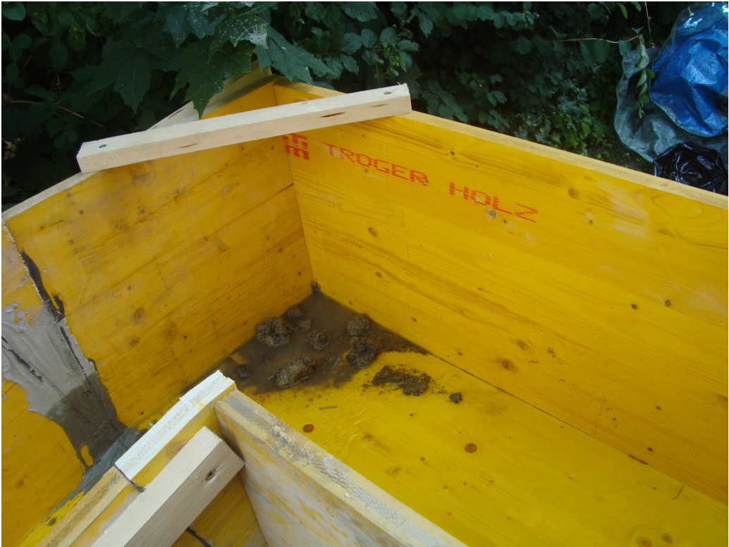
Abb. 13: Ansicht der Ecke 2 bei Zusatz von Kot, Metallteilen und Münzen nach „Aktiver Schwallspülung“ (Man beachte die Münzen, die im Hauptstrom liegen geblieben sind). – View of corner 2 during addition of excrement, metal parts and coins after “Active Surge Flushing” (note the coins which have remained lying in mainstream).
