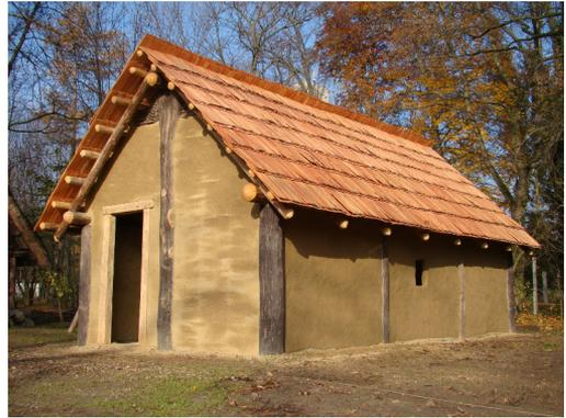
*Abb. 3: Unser fertig gestelltes Werkstättenmodell in Pfostentechnik mit Flechtwerkwänden, Lehmewurf und Lärchenschindeldach. – Our finished workshop model in post technique with wicker-work walls, loam plaster and larch shingle roof.*
